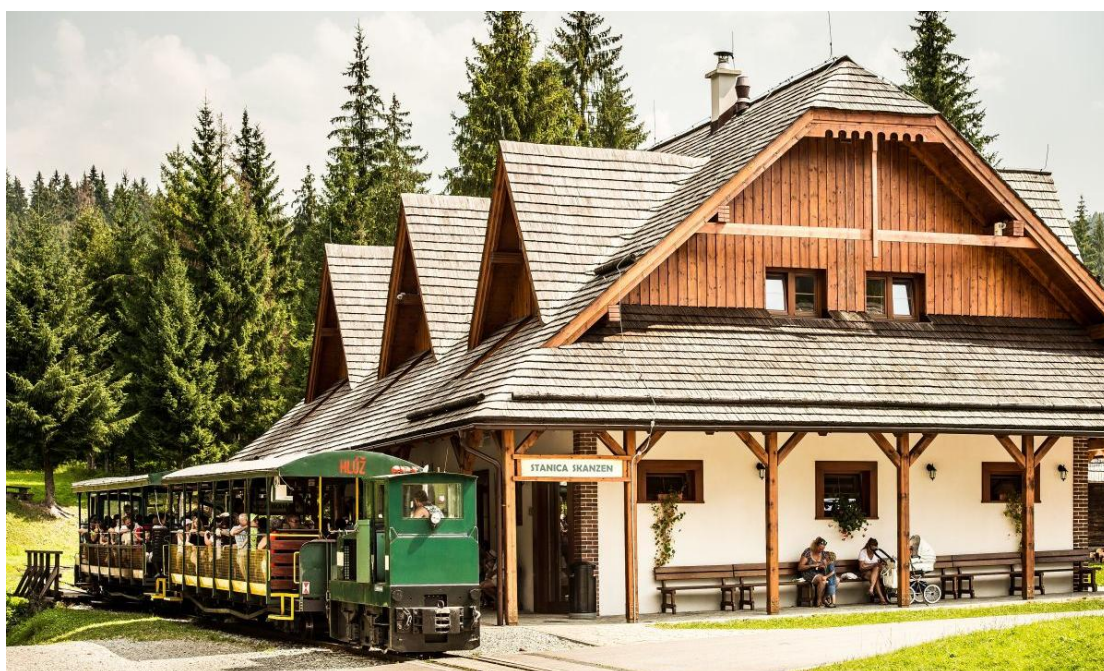
Realizovaná zákazka SOAR – hlavná stanica historickej lesnej úvraťovej železnice vo Vychylovke.
