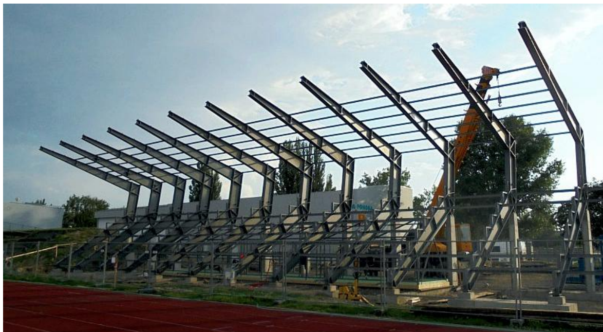
Realizovaná zákazka SOAR – tribúna atletického štadióna Trnava.
