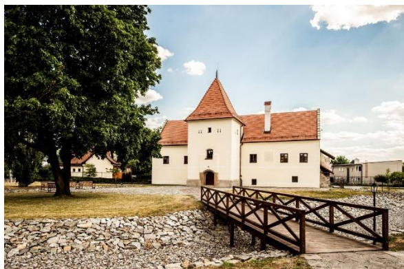
Vodný hrad, Šimonovany: Rekonštrukcia jedného z najstarších goticko-renesančných sídel sa spolu s úpravami exteriéru zaradila medzi najkrajšie stavby svojho druhu na Slovensku.
